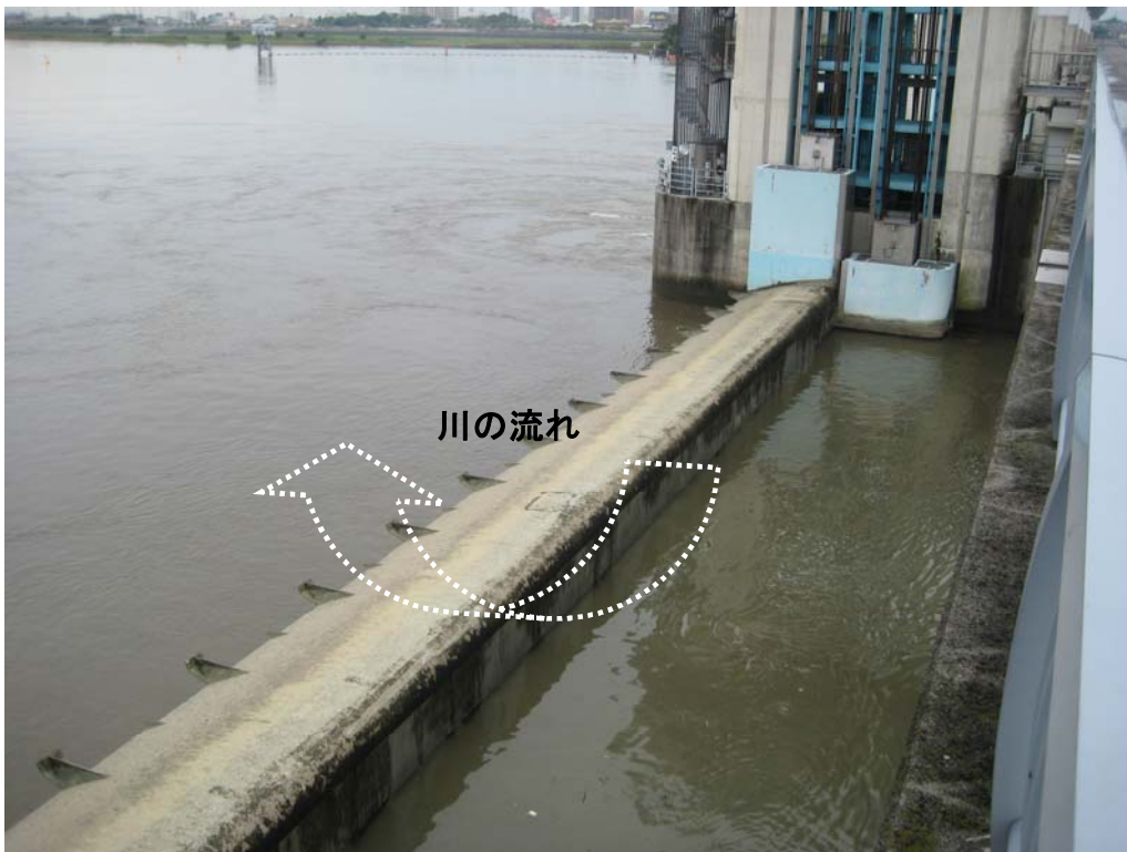
ゲート全開操作終了後の長良川河口堰（アンダーフロー操作に切り替え） 8月31日10時10分撮影
